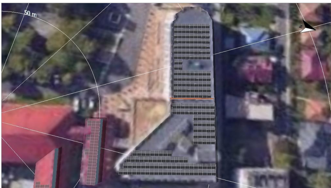
Figura: 5. Zona modulului - Arbitrary Building 02-Module Area East
